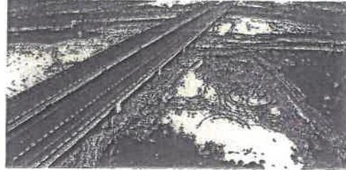
Autovía del Almanzora
