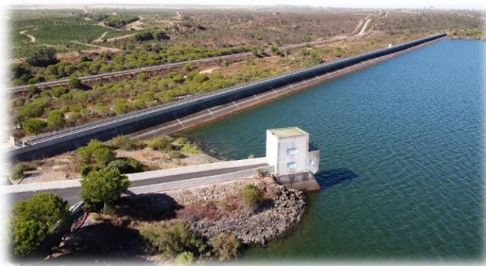
Ampliación del aliviadero de la Presa del Piedras para cumplimiento del RTSPE (Huelva), UTE MC-MEBISA
