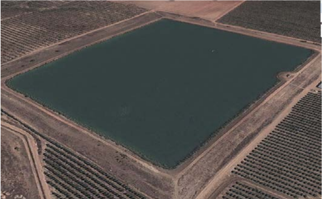
Balsa para riego a media ladera, rectangular de 370 X 325 m; muros de tierra de entre 13,5 y 1,5 metros de altura. Provista de un desagüe de fondo formado por 3 tuberías de 500 mm y aliviaderos de superficie.
