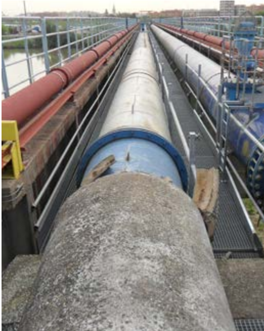
Estado final de la nueva tubería.
