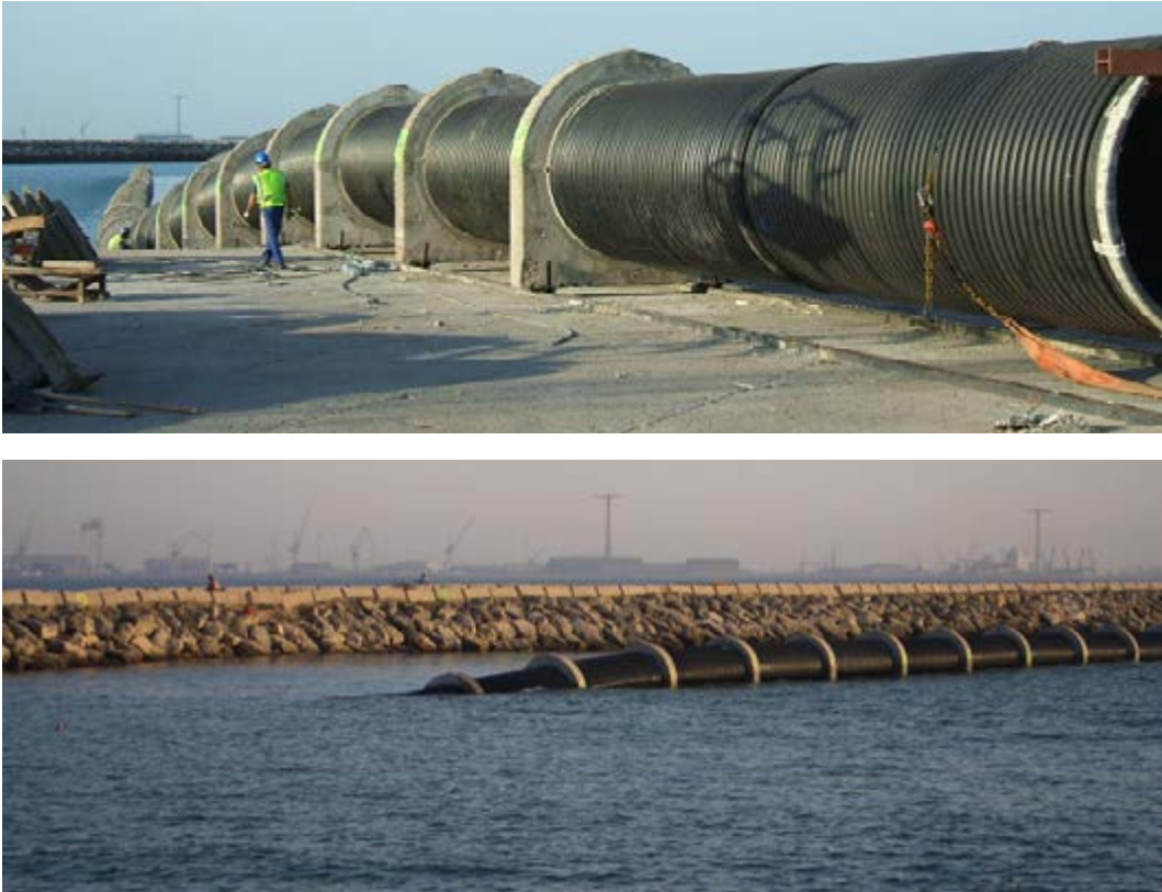
Instalación de 800 ml de emisario submarino de polietileno alta densidad (PEAD) de 2.000 mm de diámetro en la Bahía de Cádiz.
