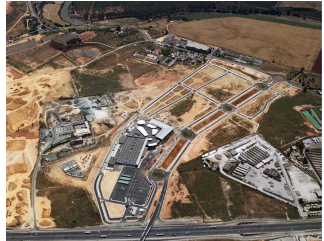
Obras de infraestructuras y urbanización en Cabeza Hermosa, parque de oficinas y comercial de más de 65 hectáreas de superficie.
