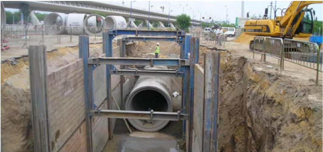
Reparación en un colector de aguas residuales.
